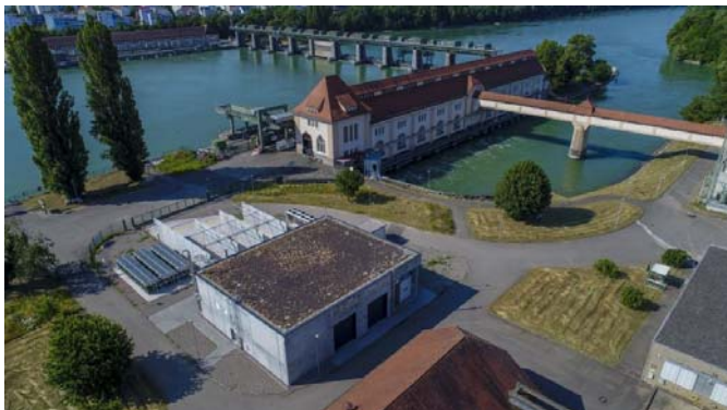
Die industrielle Power-to-Gas-Anlage am Wasserkraftwerk in Grenzach-Wyhlen.
